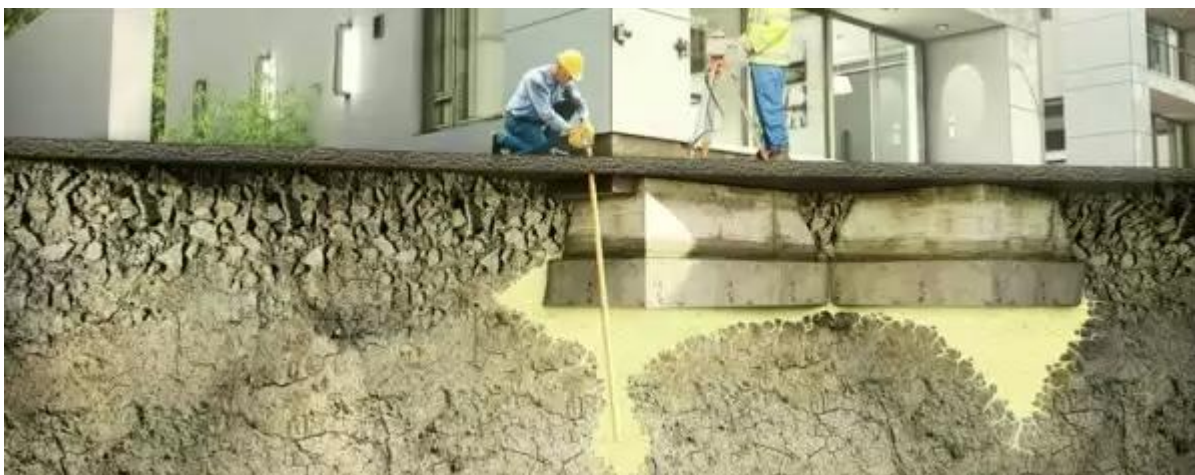
Упрочнение оснований под фундаментом
