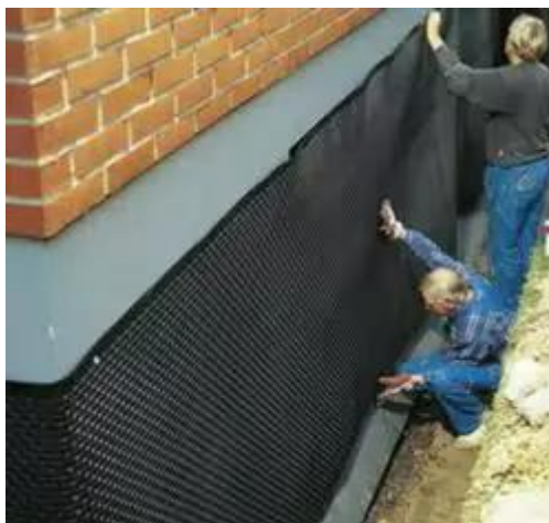
Подготовка к усилению фундамента
