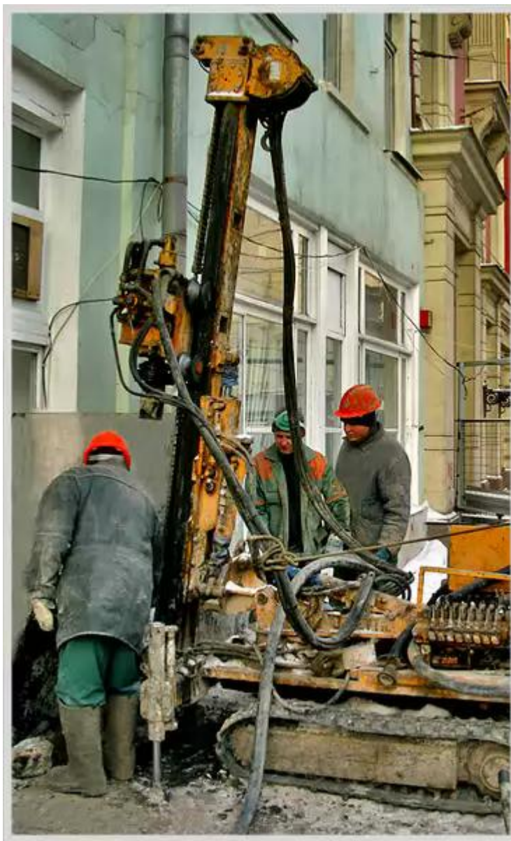
Упрочнение грунтов буроинъекционным способом
