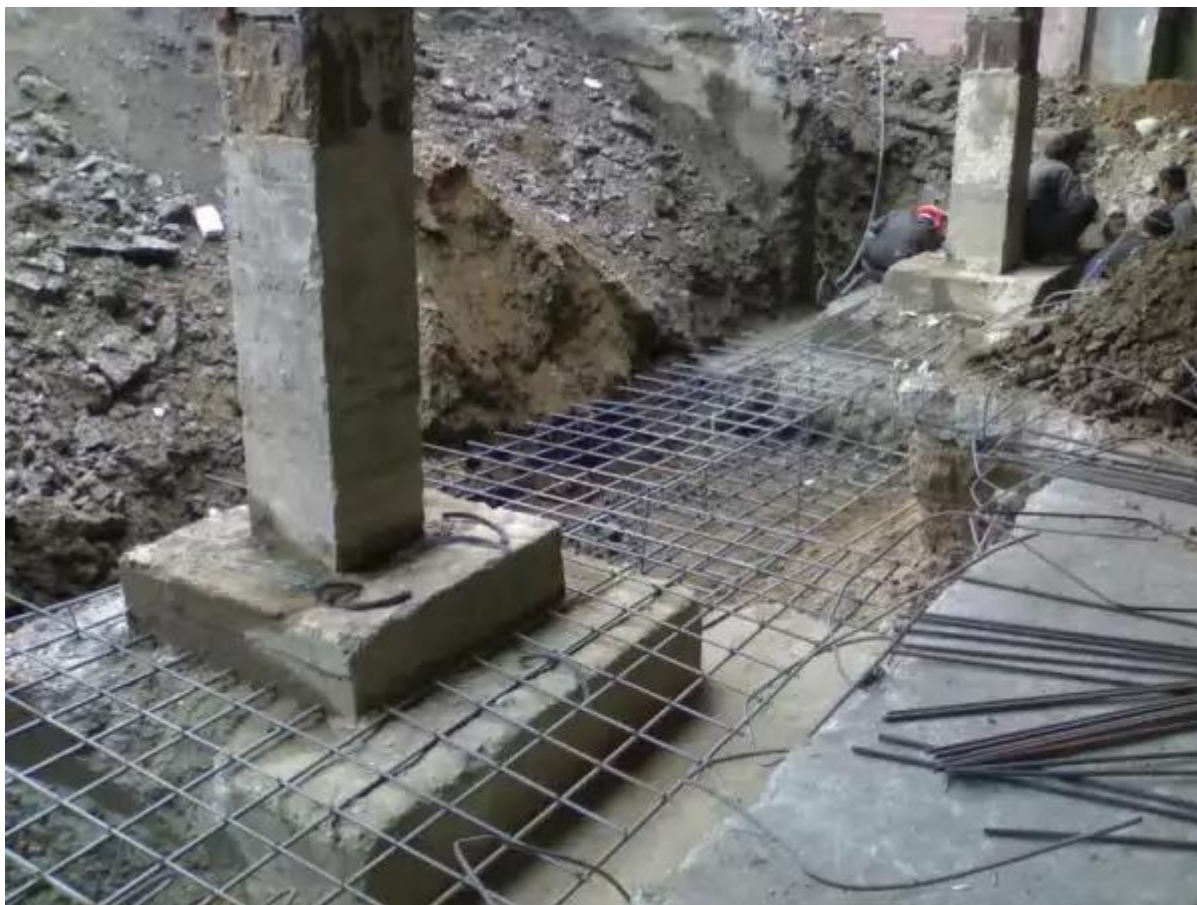
Упрочнение фундаментов столбчатых
