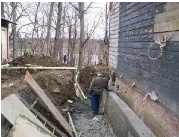
Усиление фундамента ленточного железобетонной обоймой
